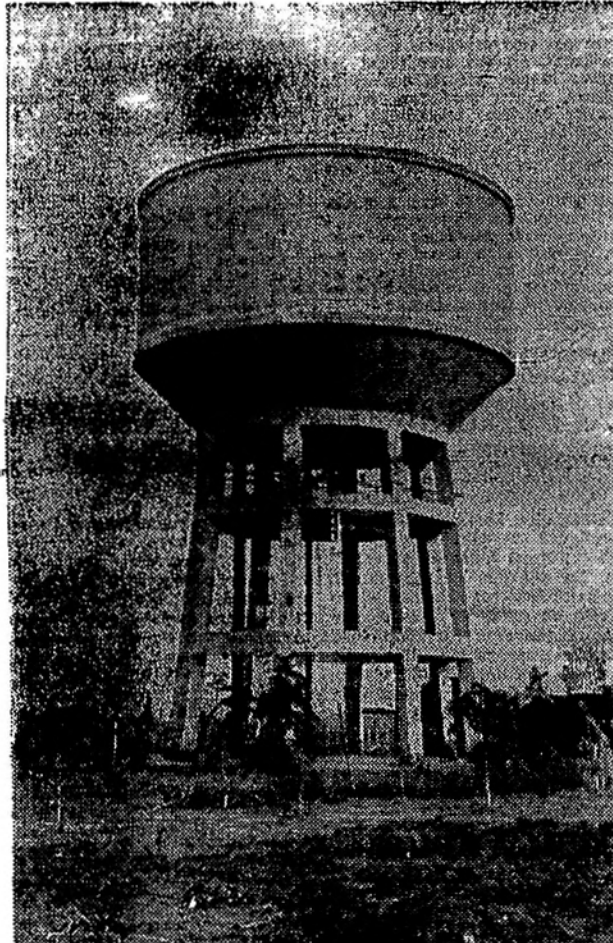
Reservatório elevado do serviço de água com capacidade de 650.000 litros
